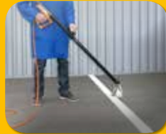
Thermoplastische Fahrbahnmarkierung
